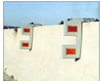
Particolare montaggio delineatore con spinotto ad incastro su New Jersey provvisto di fori
