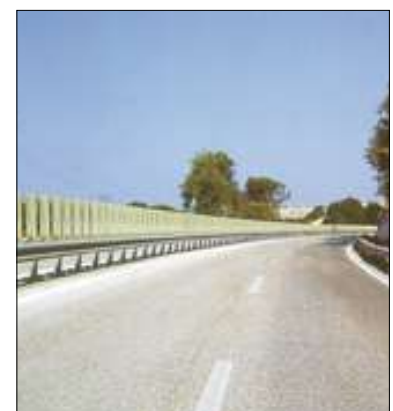
Tratto stradale provvisto di frangiluce
